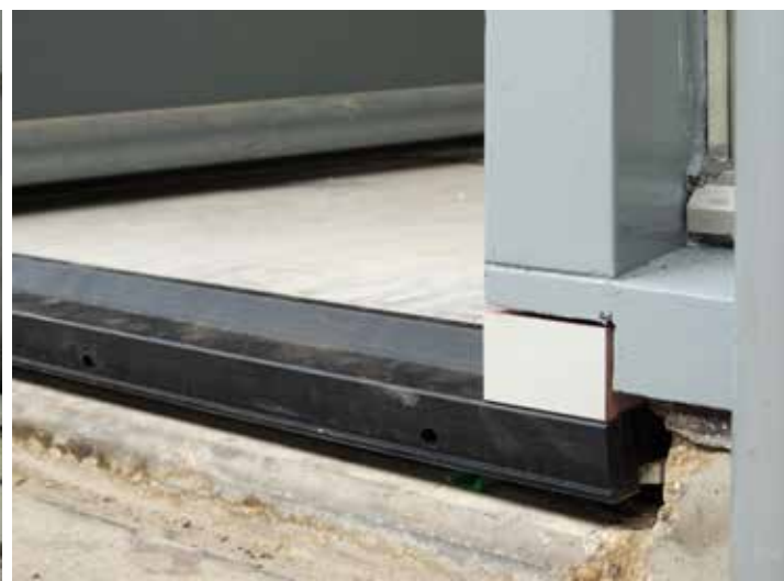
Bestaande dorpel verwijderd en betonrand weggezaagd
