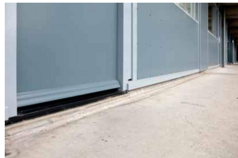
De nieuwe situatie waarbij de opstap 7cm is verlaagd
