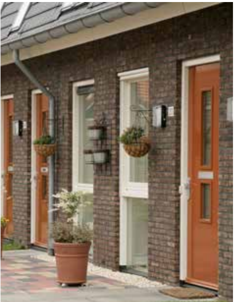
△ GORINCHEM RENOVATIE KEGAPRO 54 MM
