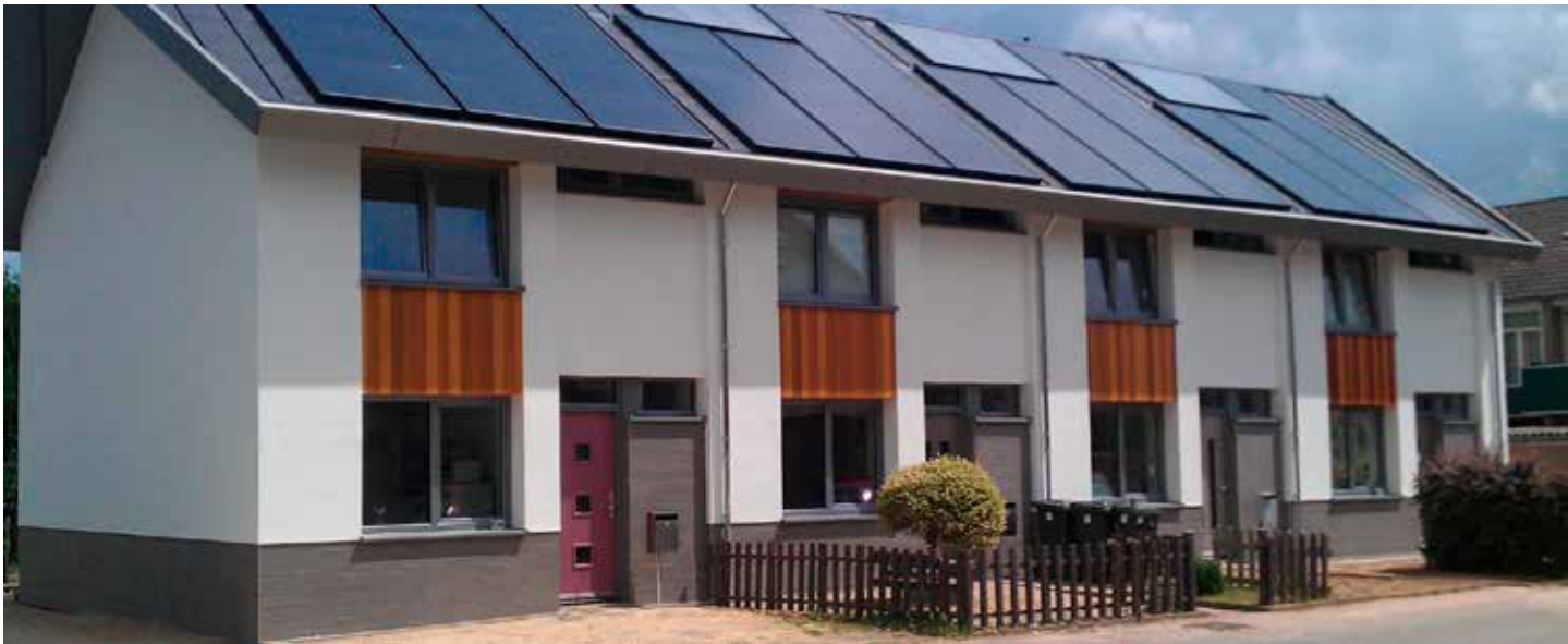
△ 153 WONINGEN, KERKRADE DUURZAME RENOVATIE, KEGAPRO+ (ENERGIEBESPARENDE VOOR- EN ACHTERDEUREN)
